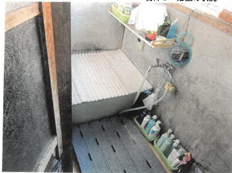
物件5 浴室の状況
