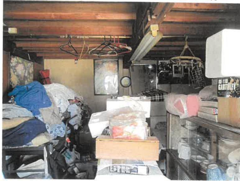
物件2 1階 和室の状況
