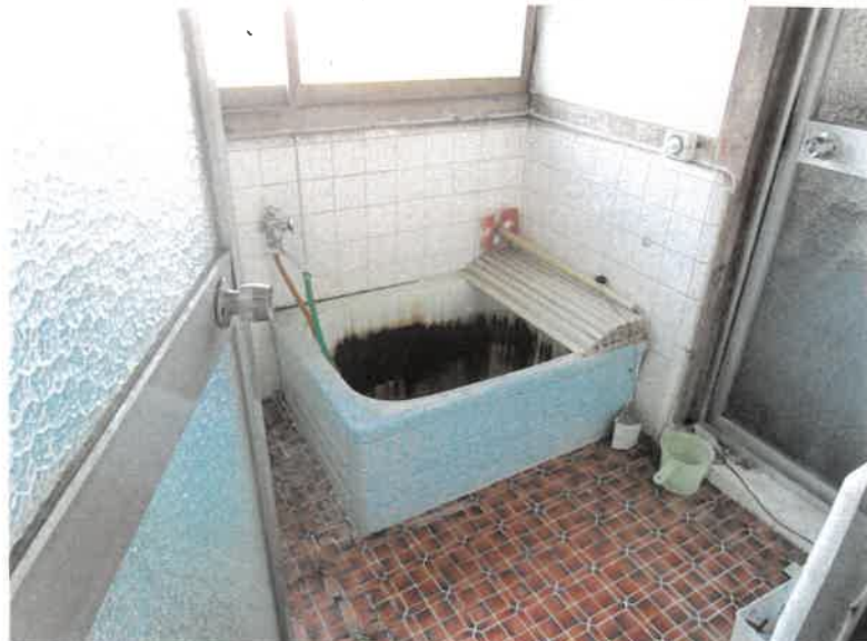
物件1主である建物 浴室の状況
