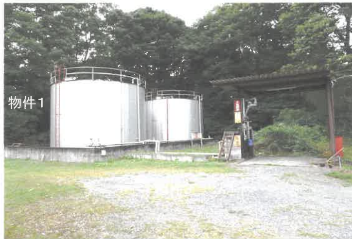
危険物貯蔵タンク等構築物
