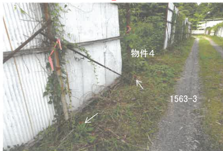
件外土地1560-10の南側の状況(矢印はプラスチック杭)
