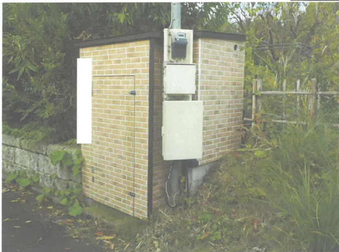
写真中央が木製井戸ポンプ小屋(工作物)です。 写真No.5、6とも、やむなく対象外の土地が写り込みます。
