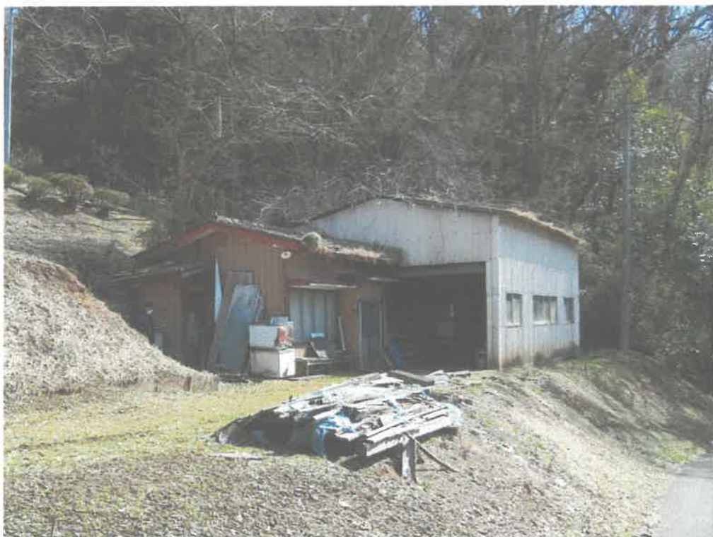
物件 1 5 未登記 附属建物①
