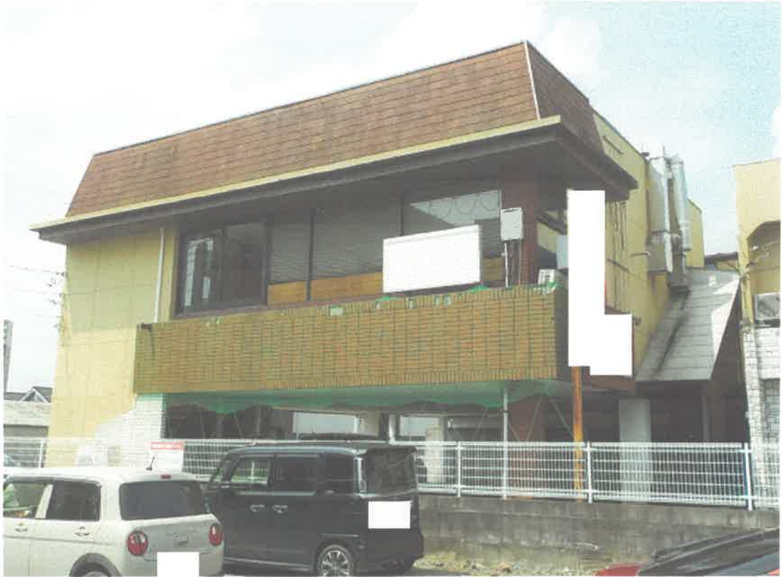
一部においてマスキングをしています。写真中央は物件8です。 近隣の公道から撮影しました。よって写真手前の土地は競売の対象外です。
