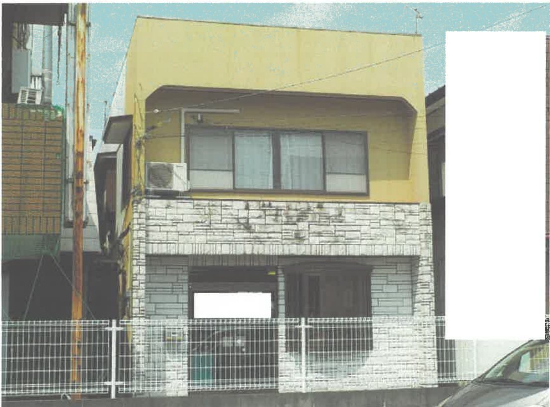
上欄同様に近隣の公道から撮影しました。写真中央は物件9です。 よって写真右端の隣家は競売の対象外です。写真左端は物件8の一部です。
