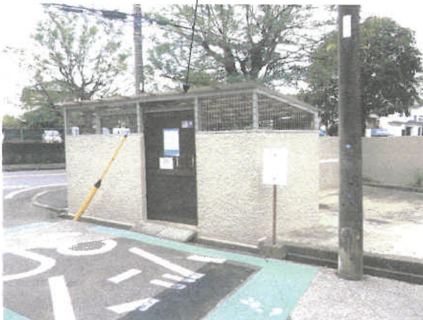
未登記附属建物2 (ゴミ置場)
