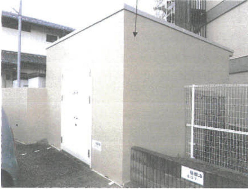
未登記附属建物1 (電気室)
