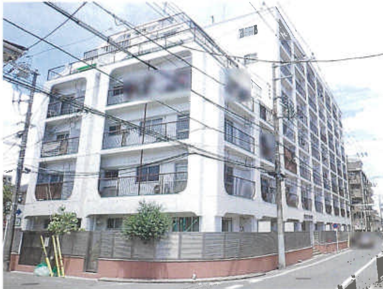
本建物を含む一棟の建物 ①
