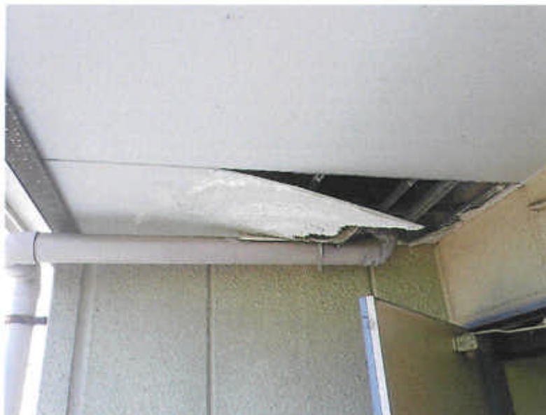
ゴミ置場（未登記附属建物） ③②
