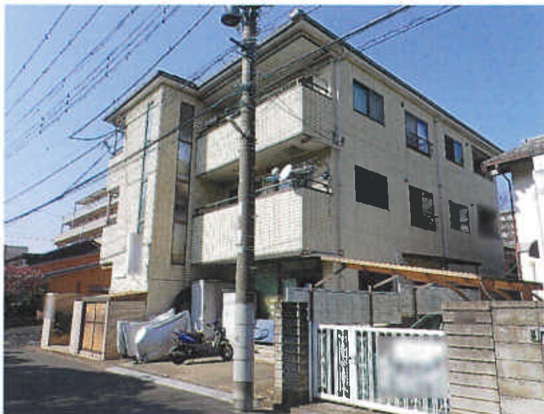
事務所部分（事務所）②
