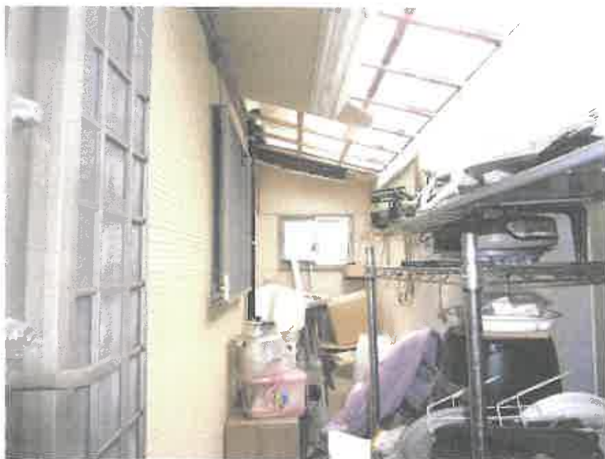
下屋（物置）の内部の状況
