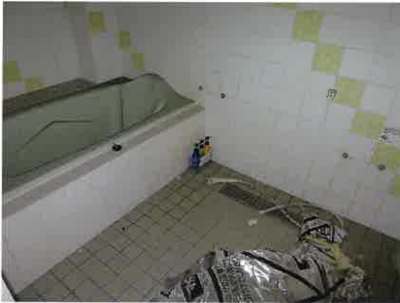
⑦ 111号室(浴室)
