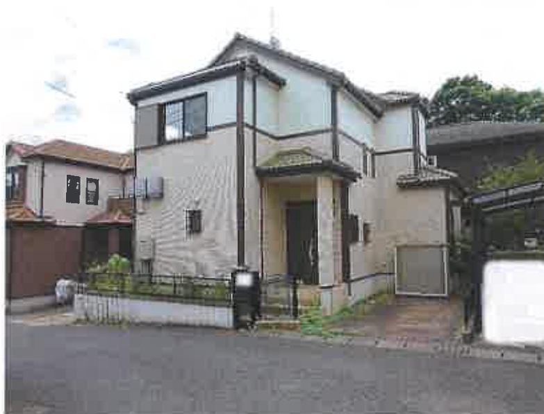
物件1の土地（北東側の外構）②
