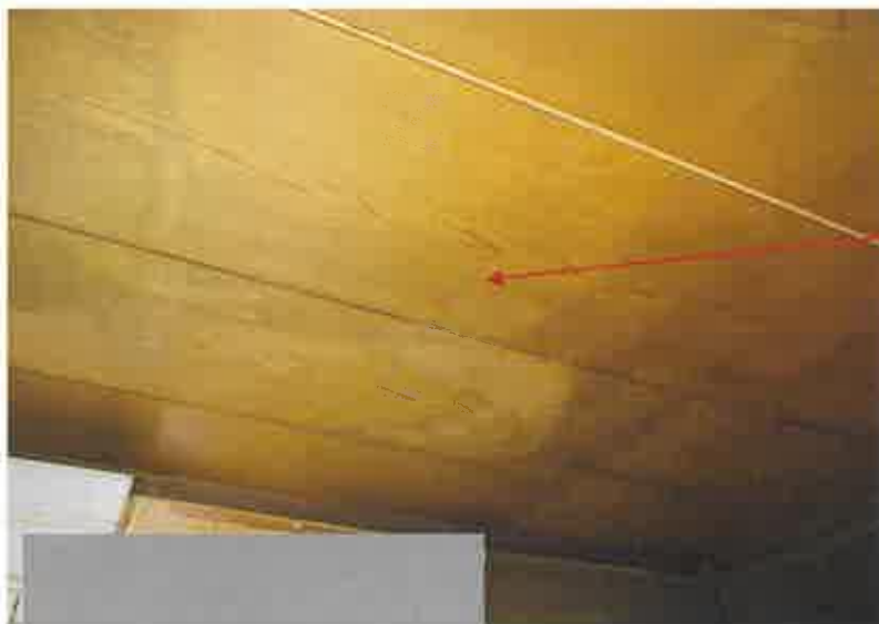
雨漏りの跡(推測)
