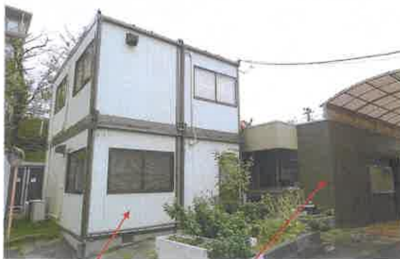
物件2附属建物の増築部分
