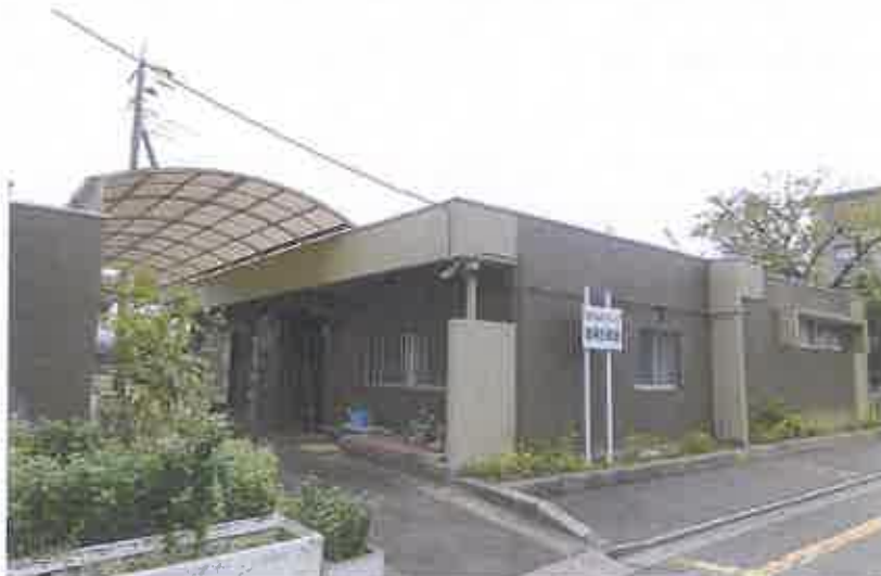
物件2主たる建物
