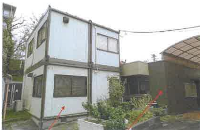
物件2附属建物の増築部分
