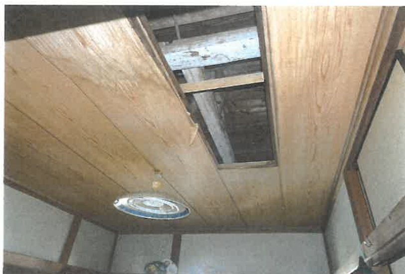
2階和室Bの天井
