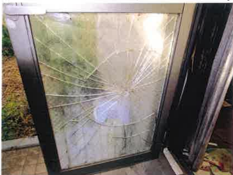
ドアガラスの破損
