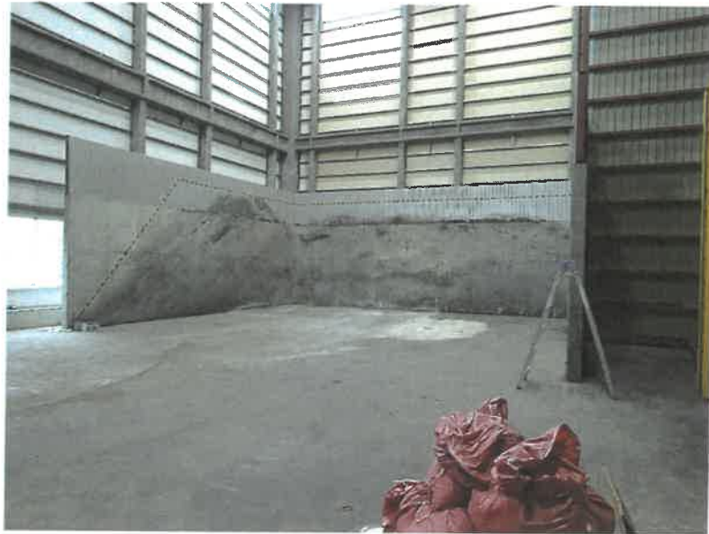
物件2の建物（工場（養生保管室部分））⑧
