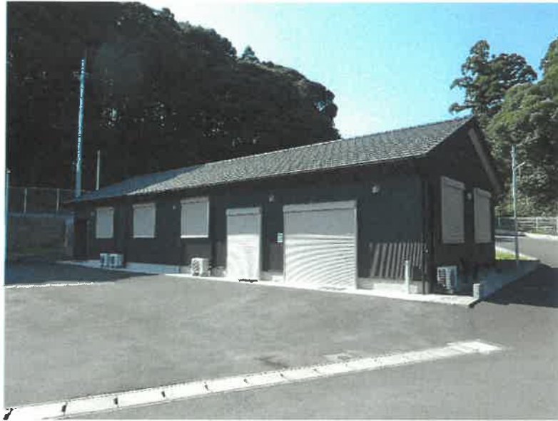
物件2の建物（附属建物（符号2：便所））⑤
