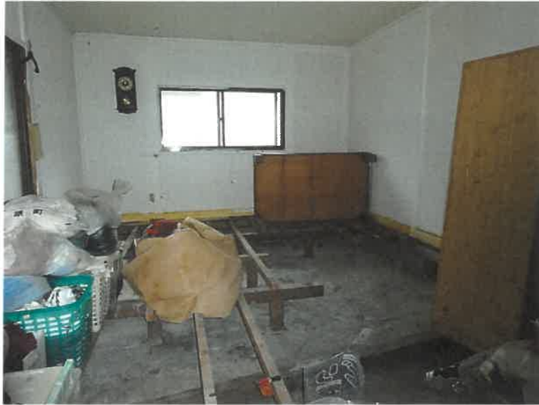
物件2の建物（未登記附属建物）（物置（西側））⑦
