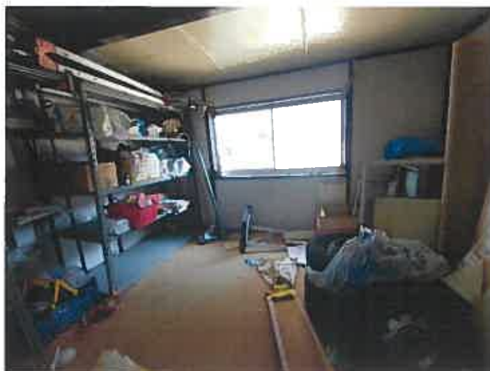
未登記附属建物 の内部
