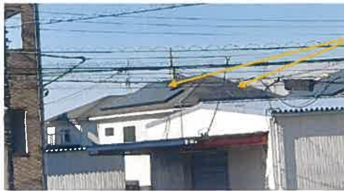
太陽光パネル
