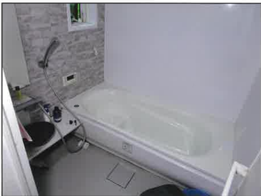
④ 建物内の状況ー浴室(1階)
