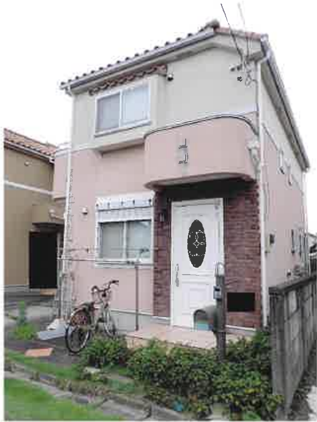
① 目的物件北東側の状況
