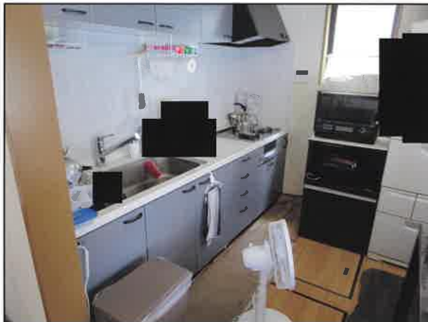
③ 建物内の状況ーキッチン(1階)
