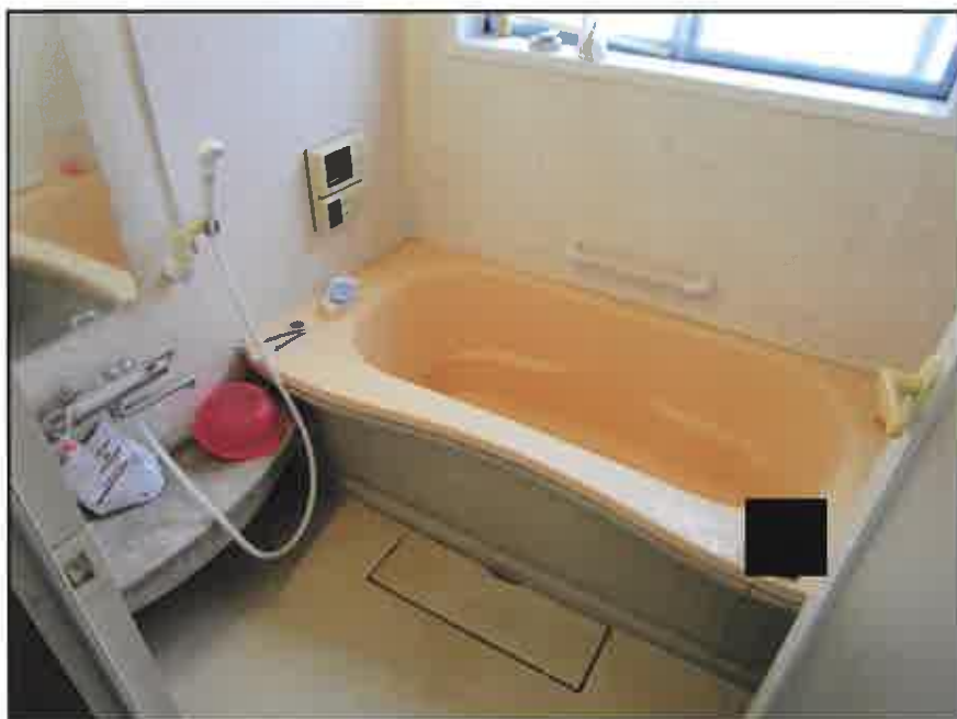
④ 建物内の状況－浴室(1階)
