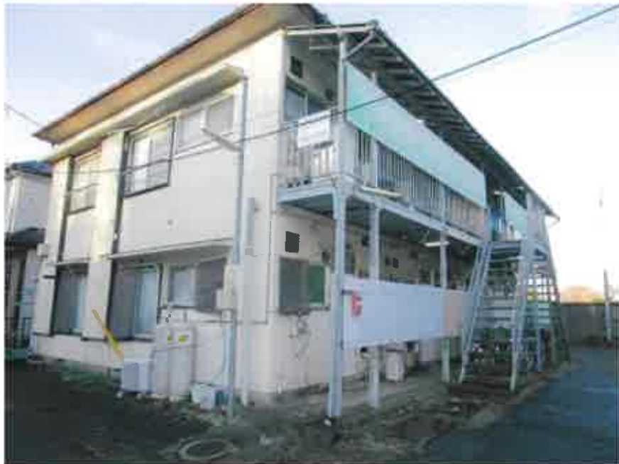
① 建物の外観
