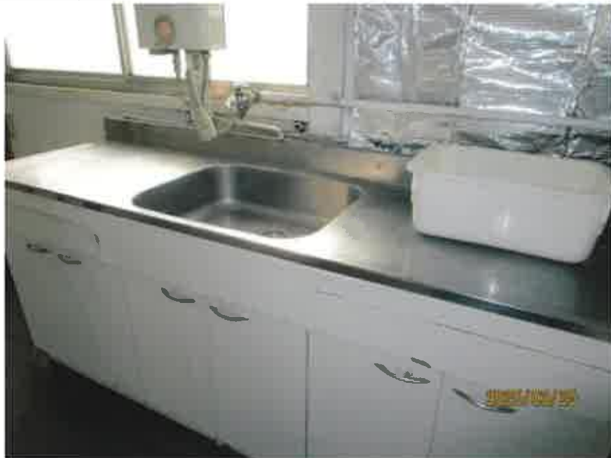
⑥ 建物内の状況
