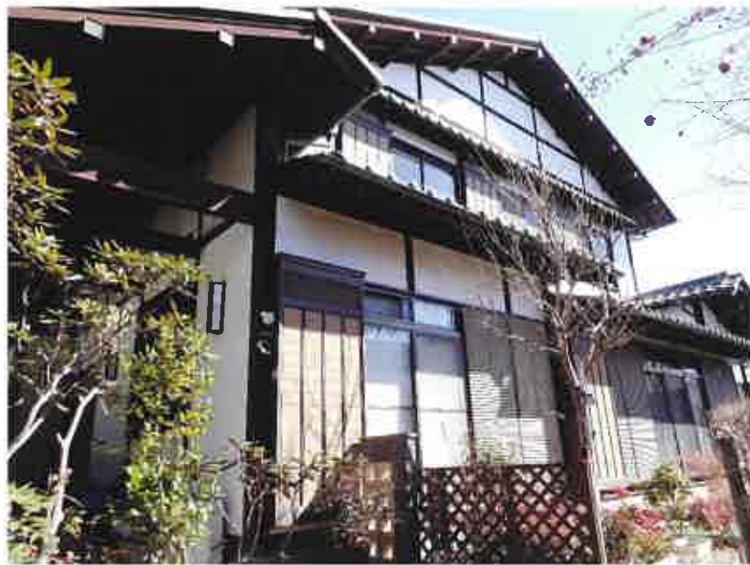
① 目的物件南西側の状況
