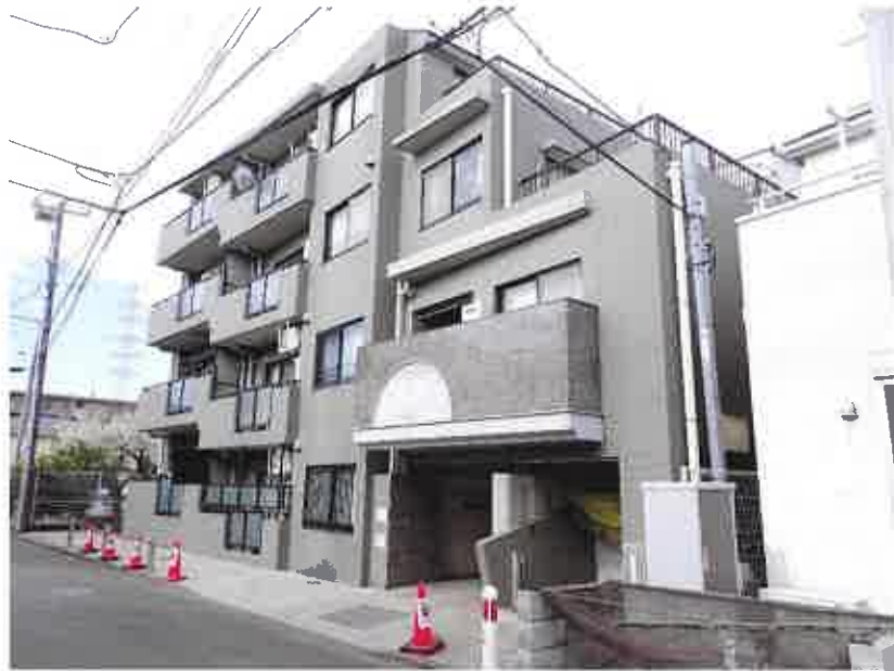
① 目的物件東側の状況
