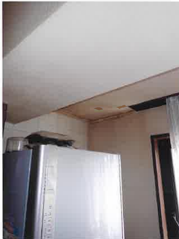
⑥台所天井水漏れによる損傷状況
