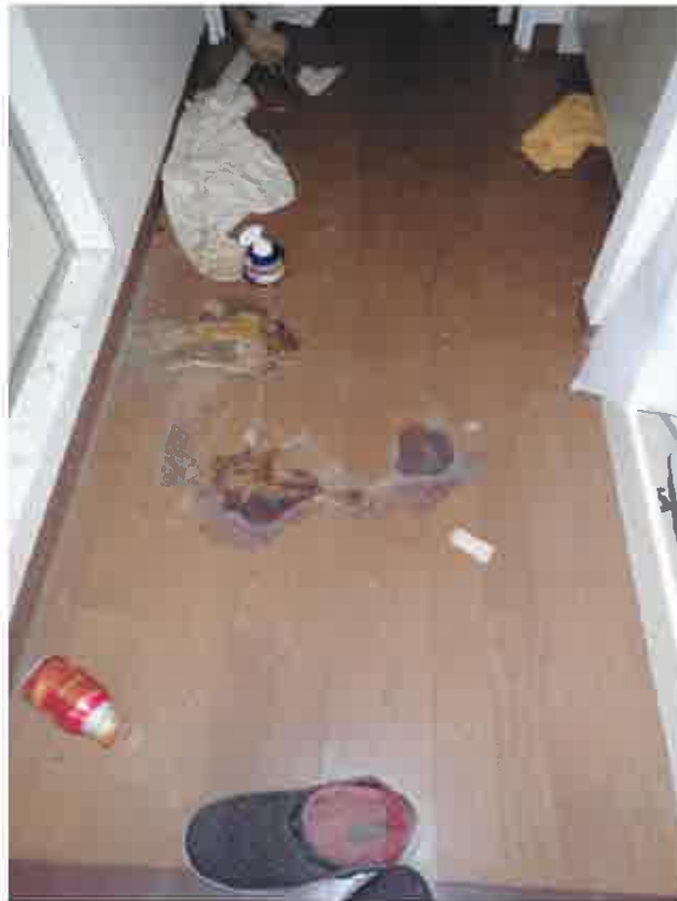
⑤廊下部分の変色、損傷の状況
