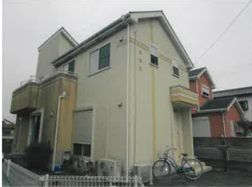
① 建物の外観
