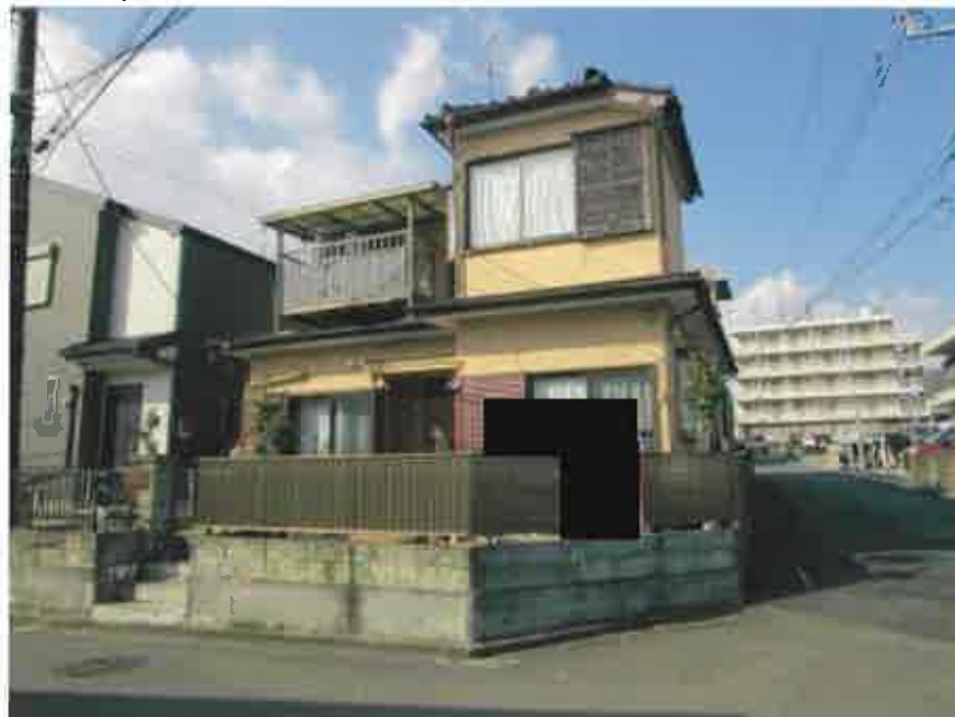
① 建物の外観
