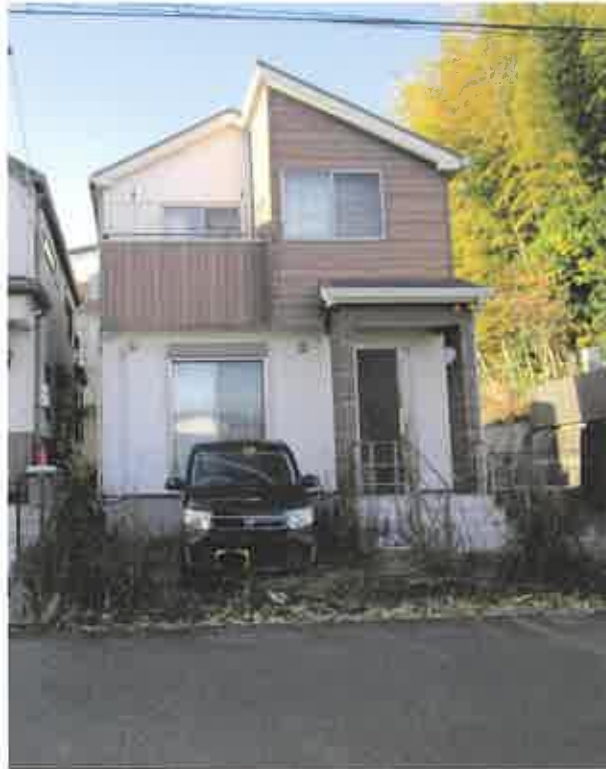
① 建物の外観
