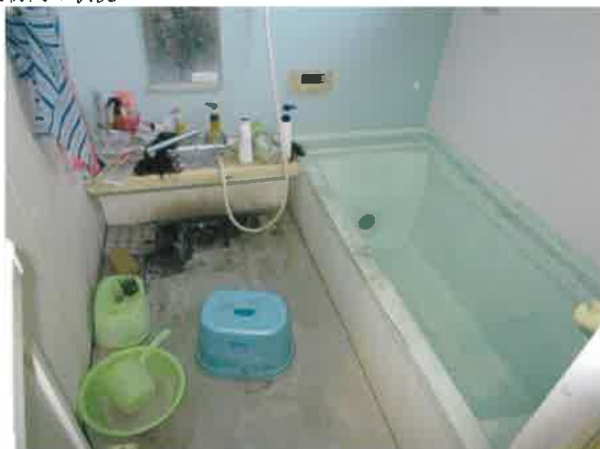
④ 建物内の状況
