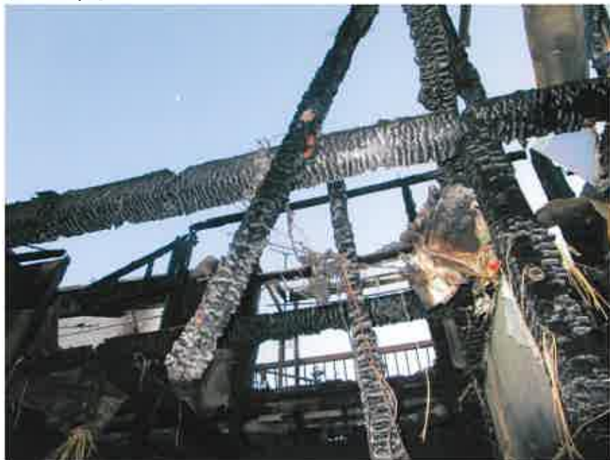
③ 建物内の状況
