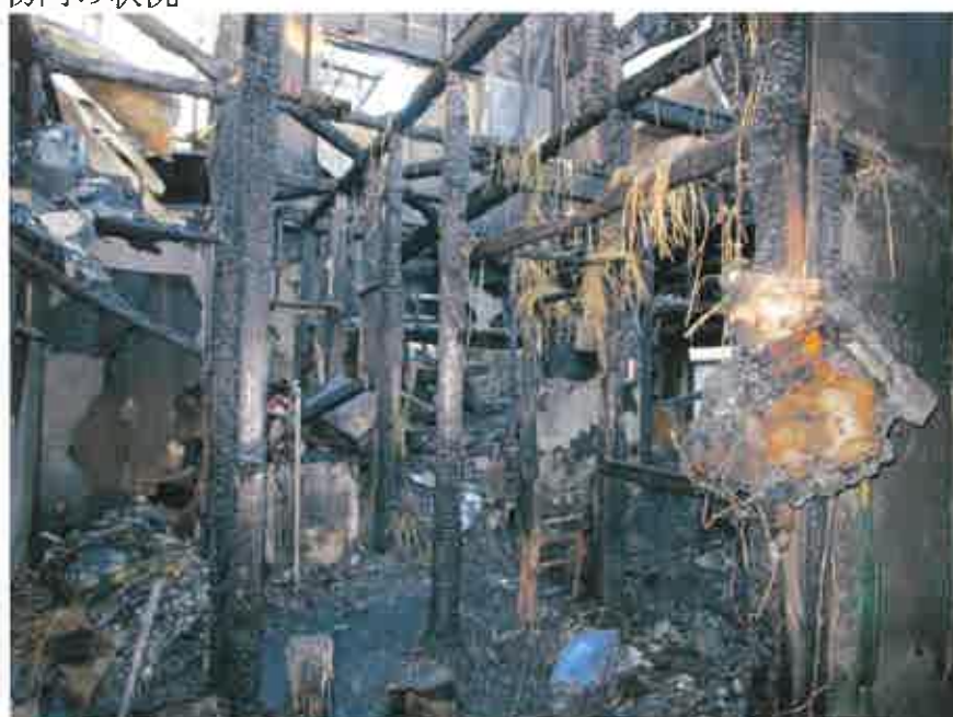
② 建物内の状況
