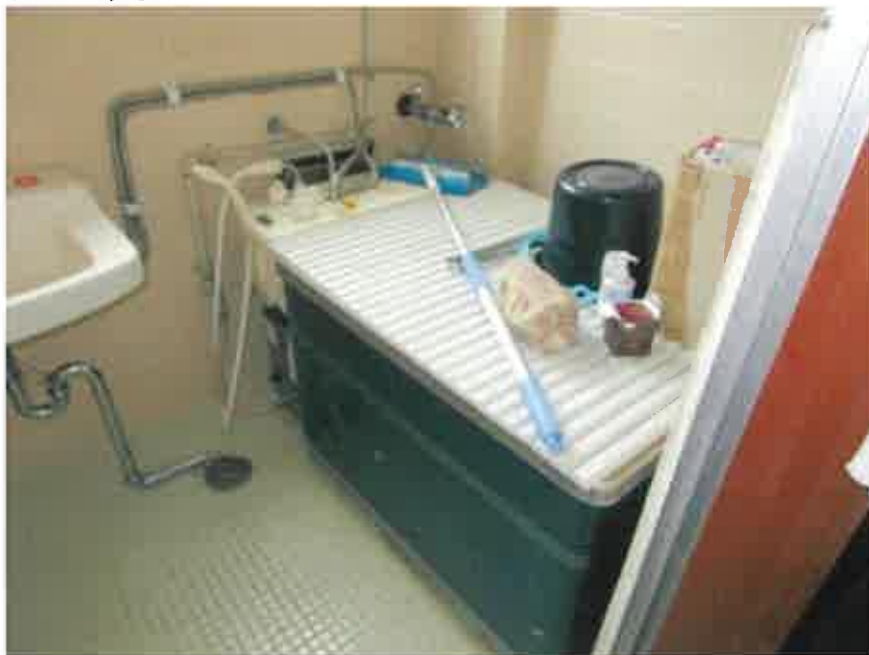
⑥ 建物内の状況
