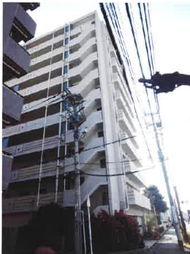
① 物件 1 を含む建物の外観
