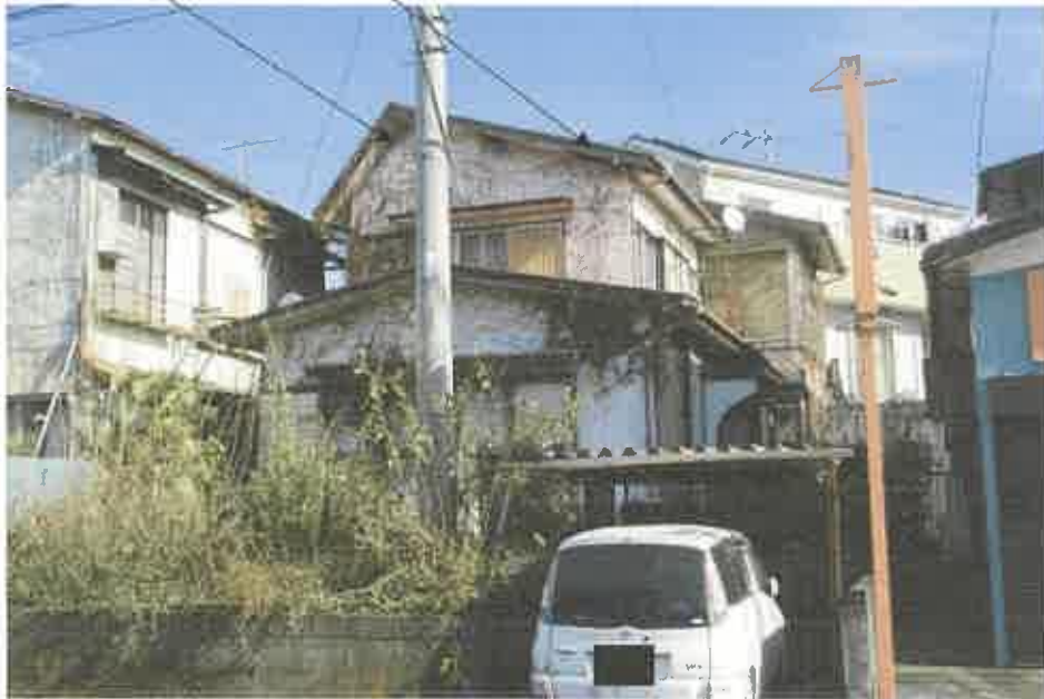
① 本土地上の電柱 軒下の破損
