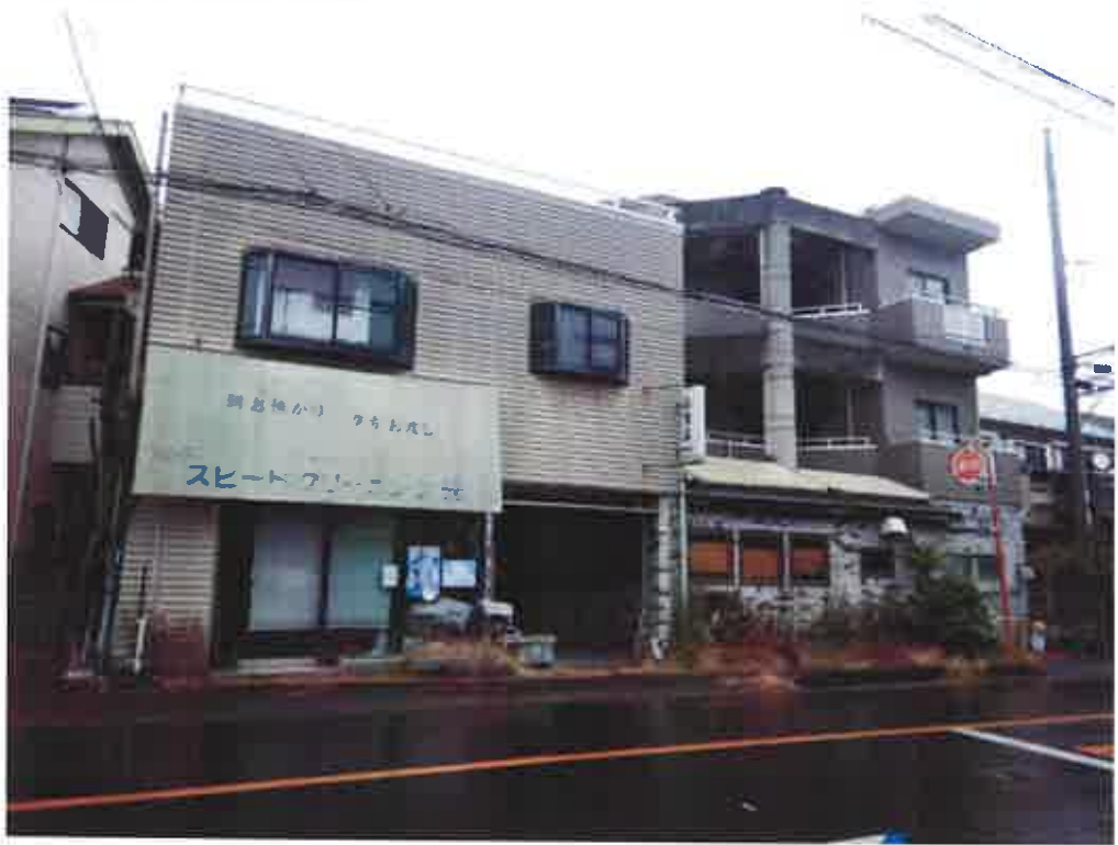
① 物件1の建物の外観
