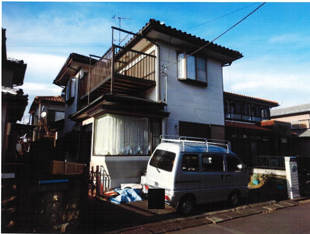
①物件 2 の建物の外観
