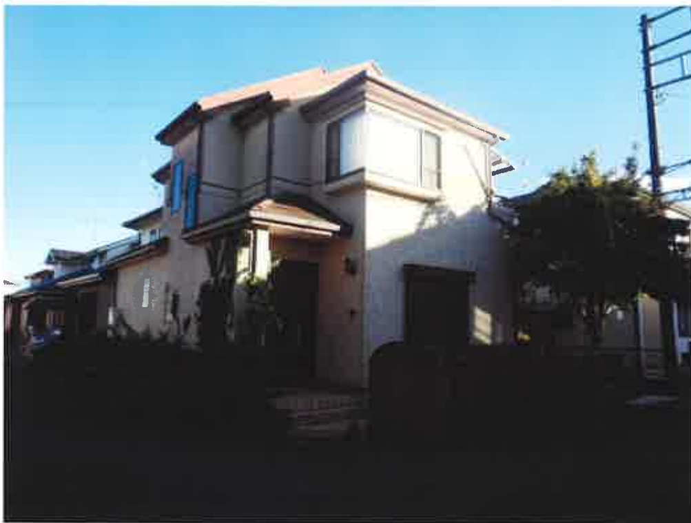
①物件2の建物の外観
