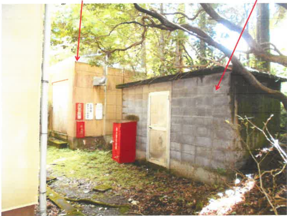
⑦ 物件11の附属建物（符号1） 物件10の附属建物（符号6）
