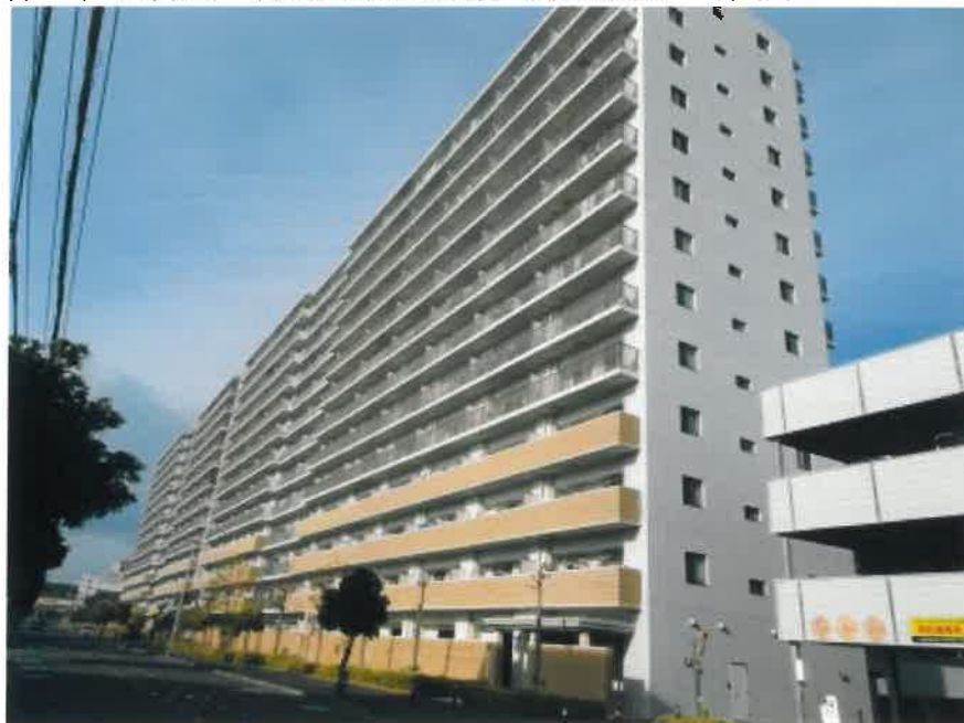
① 本件建物を含む一棟の建物の外観（東方向から撮影）
