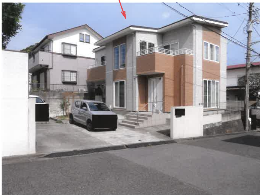
① 建物の外観（南東側から撮影）
