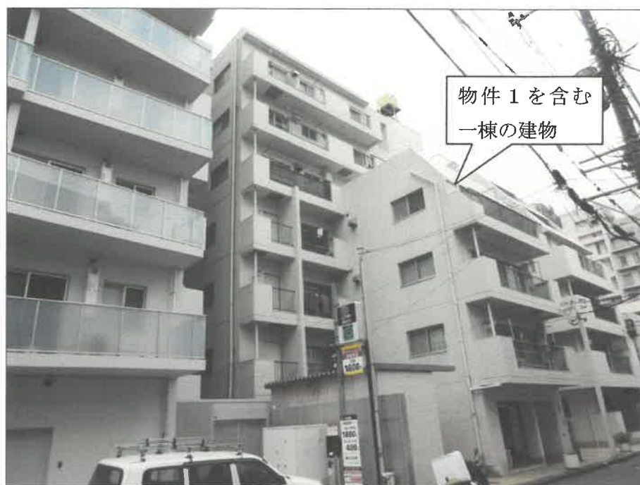
①外観（北東方向から撮影）
