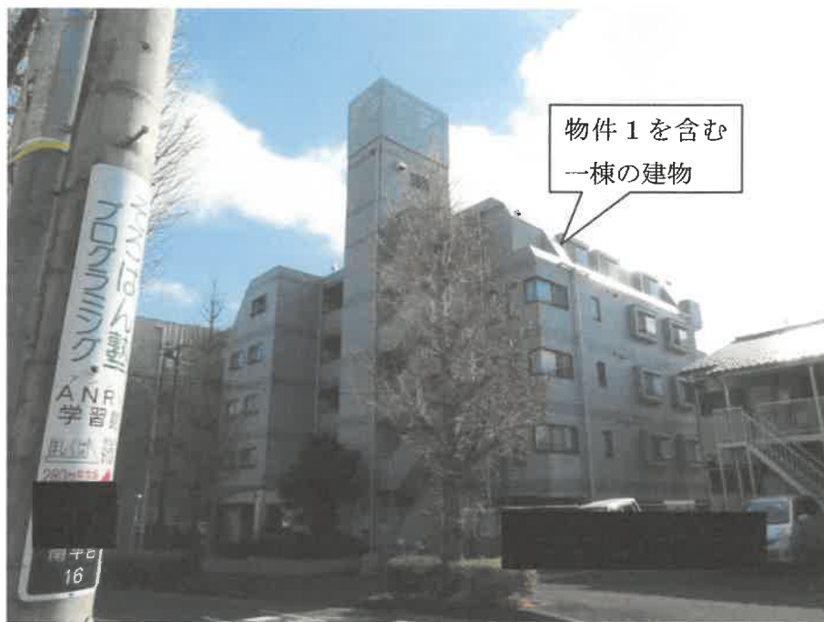
①外観（北西方向から撮影）
