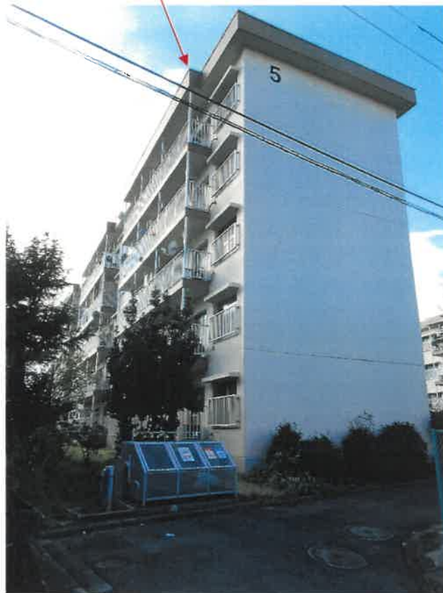
① 物件 1 を含む一棟の建物
