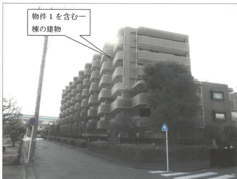
①外観（北東方向から撮影）
