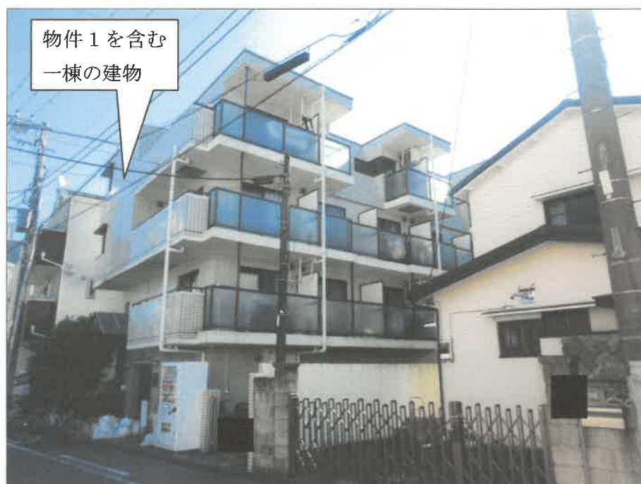
①外観（北西方向から撮影）
