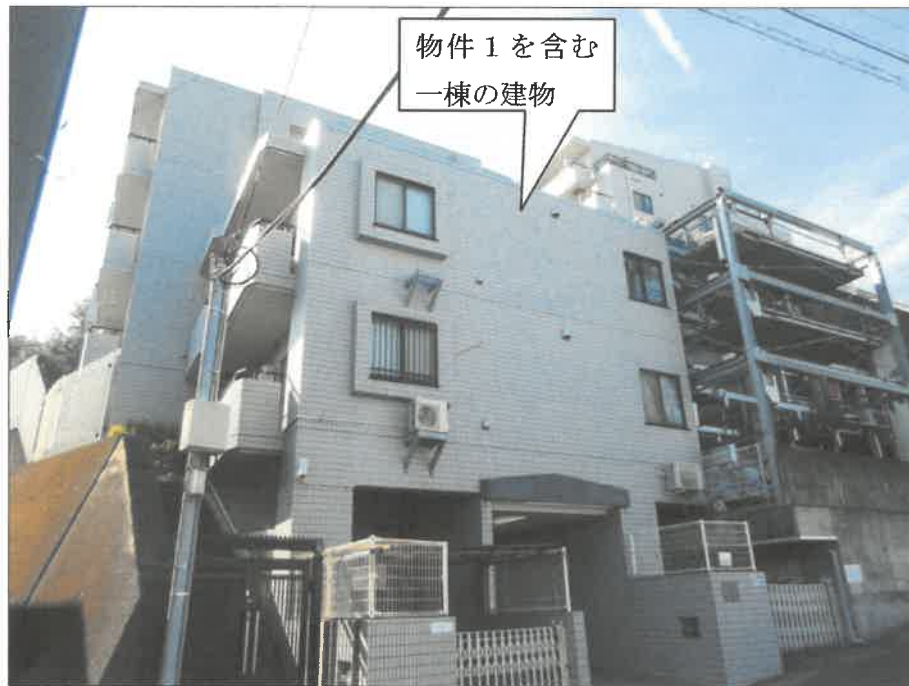
①外観（北東方向から撮影）
