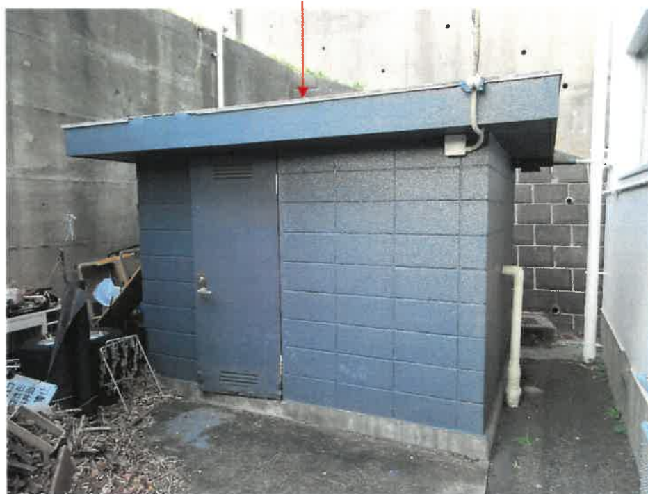
附属建物符号1 ポンプ室
