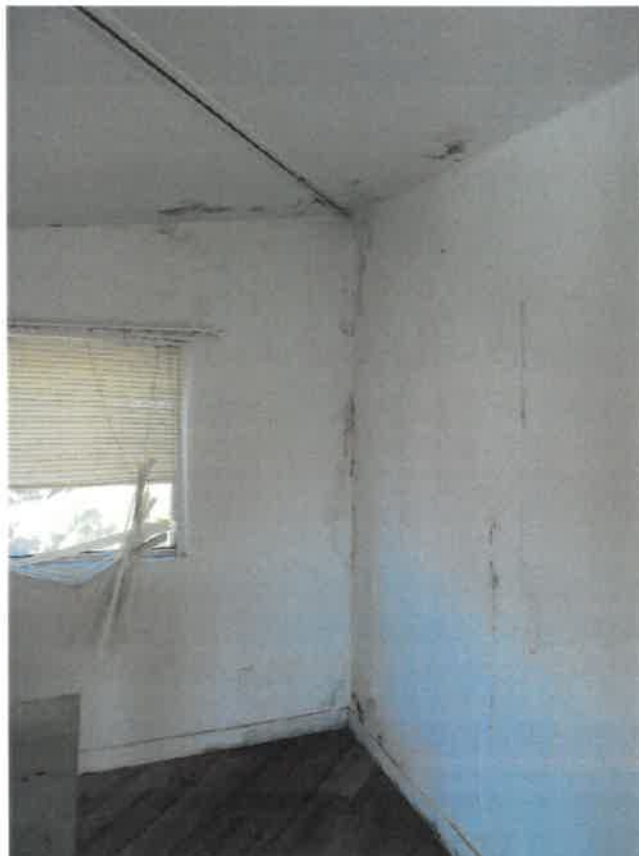
⑧ 302号室キッチン天井及び壁面のカビ、亀裂等
