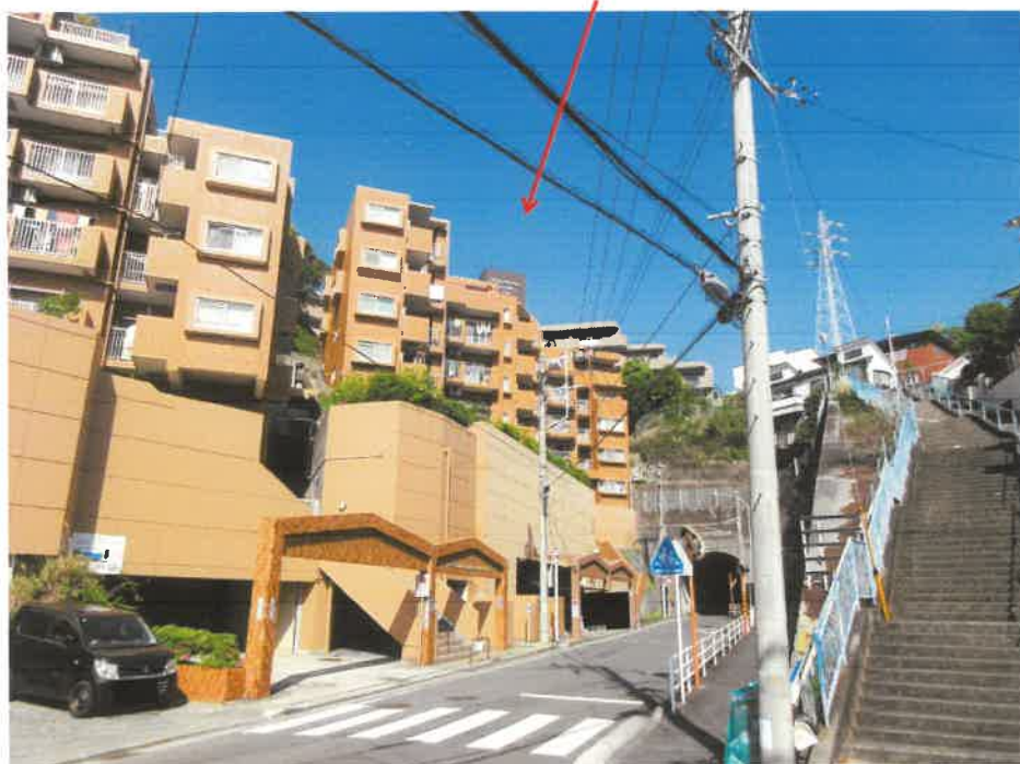
物件 1 の存する一棟の建物
